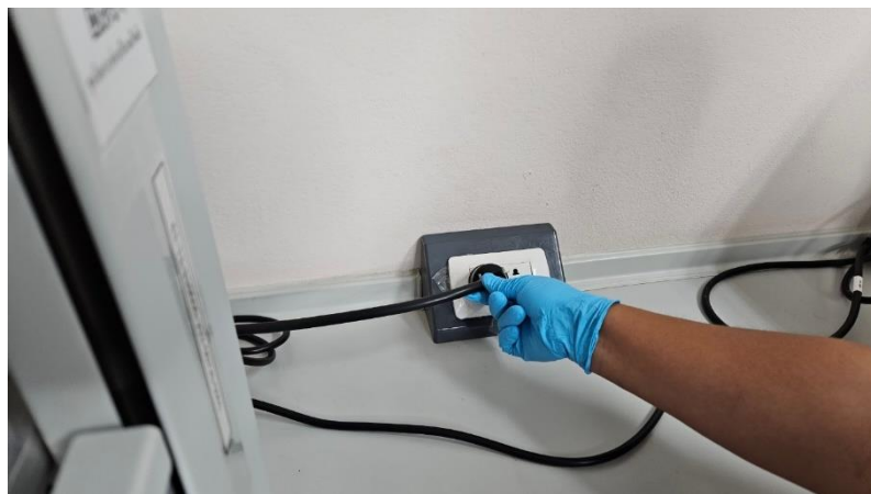
ภาพ 27 วิธีการถอดปลั๊กเครื่องควบคุมอุณหภูมิแบบน้ำหมุนเวียน
