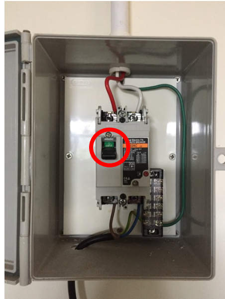
ภาพ 8 การปิดเบรกเกอร์ไปที่ “OFF”
