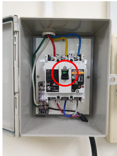
ภาพที่ ๒๐. แสดงลักษณะของเบรกเกอร์ off
