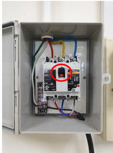
ภาพที่ ๑๒. แสดงลักษณะของเบรกเกอร์ on
